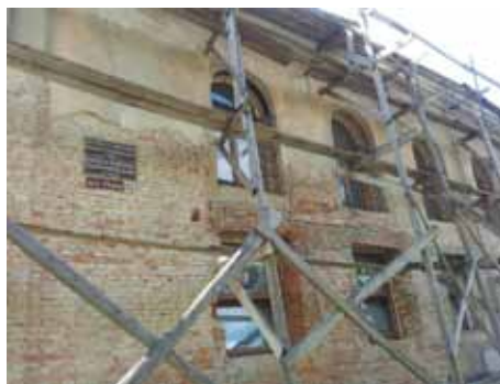
Zdjęcia remontowanego kościoła rzymskokatolickiego w Chyrowie
