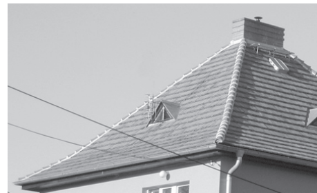
Dach po wykonaniu remontu
